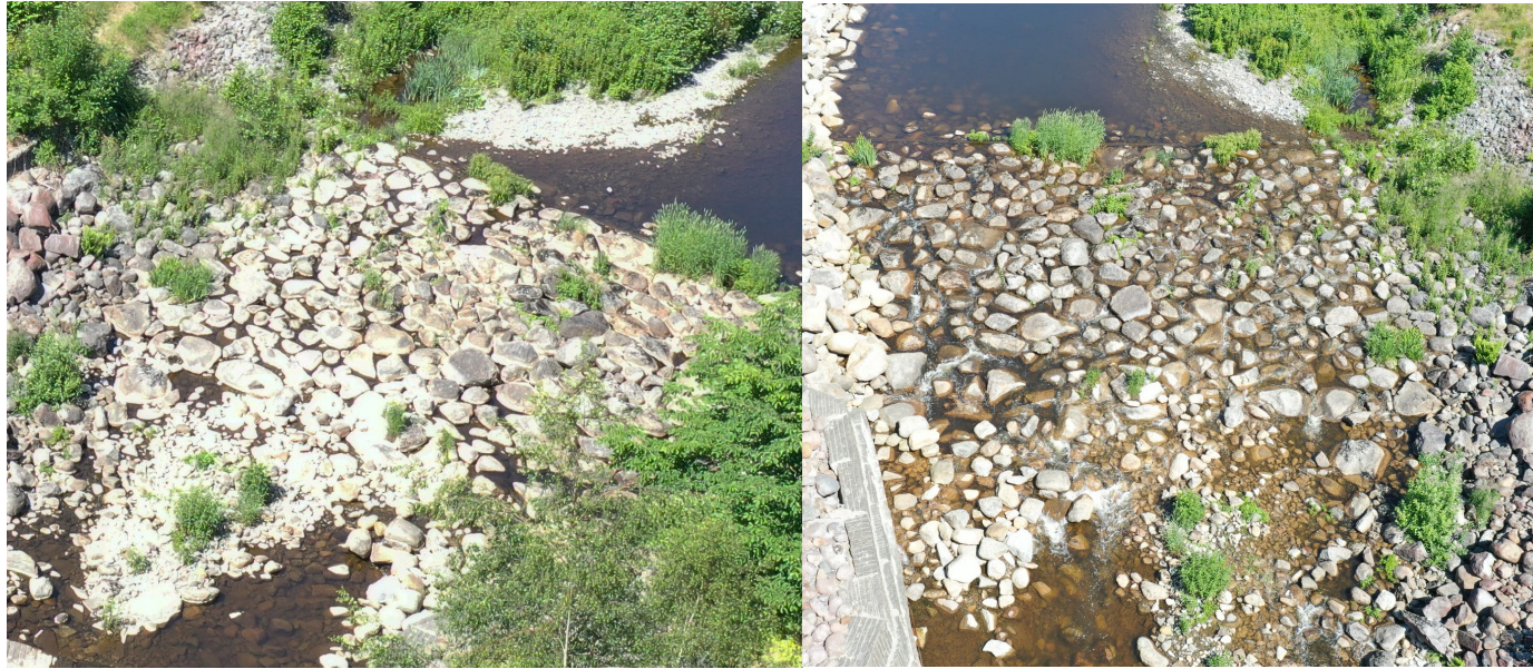
Figur 22 Terskel nr. 2 ovenfra den 21. juni 2023 med lav sommervannføring til venstre og med slipp av 300 l/s fra Farrisdammen til høyre. Samling av vannføringen i et løp vil gi oppvandringsmuligheter for fisk (Fig. 12).
