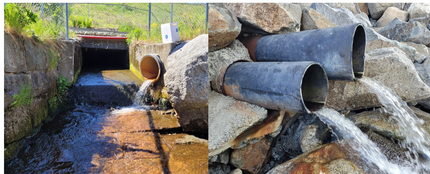
Figur 4 Knappenålsbekken og vann fra togtunnel til venstre, innløp fra E 18 på østsiden av Farris til høyre (foto Sweco 30.05.2023)
