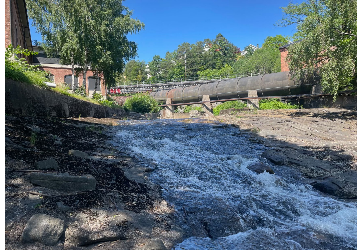
Figur 23 Nedre fosseparti rett før samløp med vannet fra kraftstasjonen. Bildet er tatt 21.06.2023 med slipp av ca. 300 l/s fra Farrisdammen. I dette partiet er planen å bruke fleksiterskler i kombinasjon med betong for tilrettelegging av hydrauliske forhold for fiskevandring.
