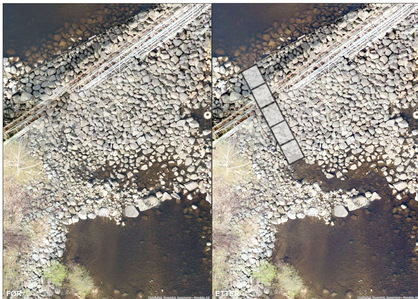
Figur 15 T7 med fisketrapp og steinplukket vandringsløp nedstrøms fisketrapp. Dette er tredje terskel regnet ovenfra E 18.
