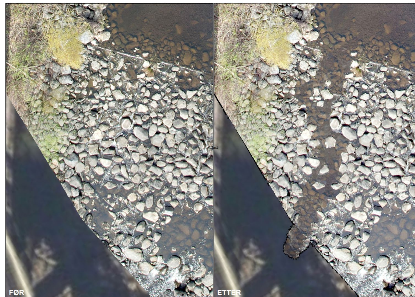
Figur 16 Steinplukket vandringsløp over nederste steinterskel. Fallet er lite, og vandringsløpet legges på vestsiden av elva.
