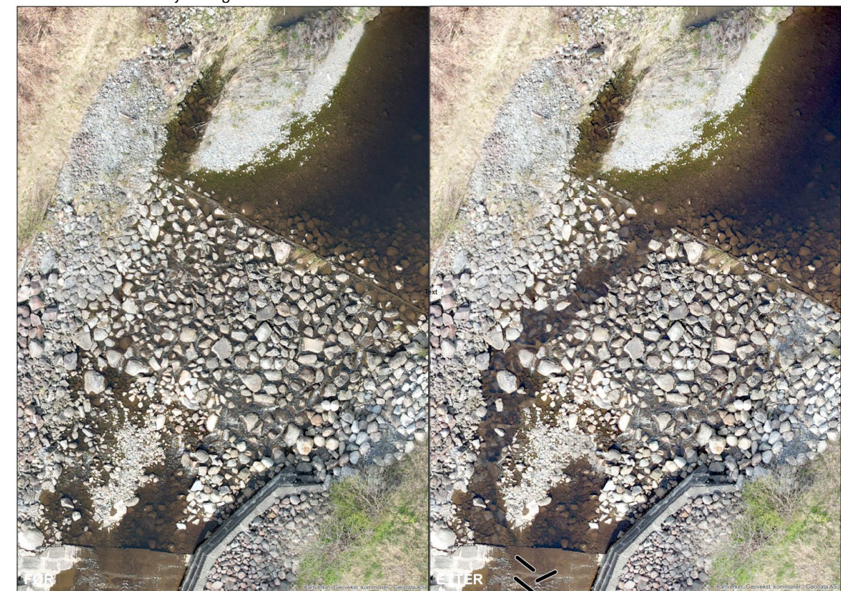
Figur 12 T5 i terskel 2 ovenfra før og etter åpning av løp for fiskevandring med kapasitet for å avlede minstevannføringen om sommeren. I før situasjonen går det ca. 80 l/s mellom steinene i terskelen.
